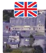
Sowerby Bridge, UK
